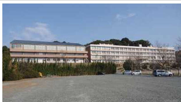
外部改修を終えた校舎棟と体育館
