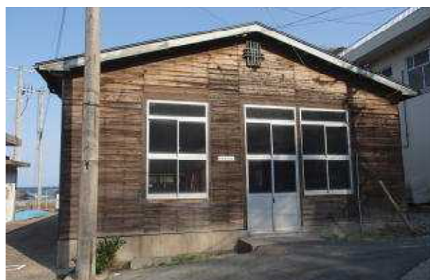
木造の原動機実習室。まだ現役です。
