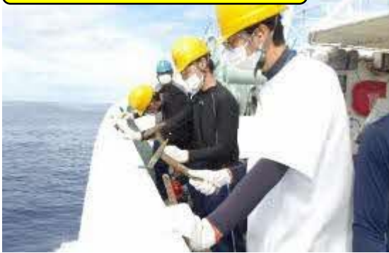
船体整備（錆部を叩いてます）
